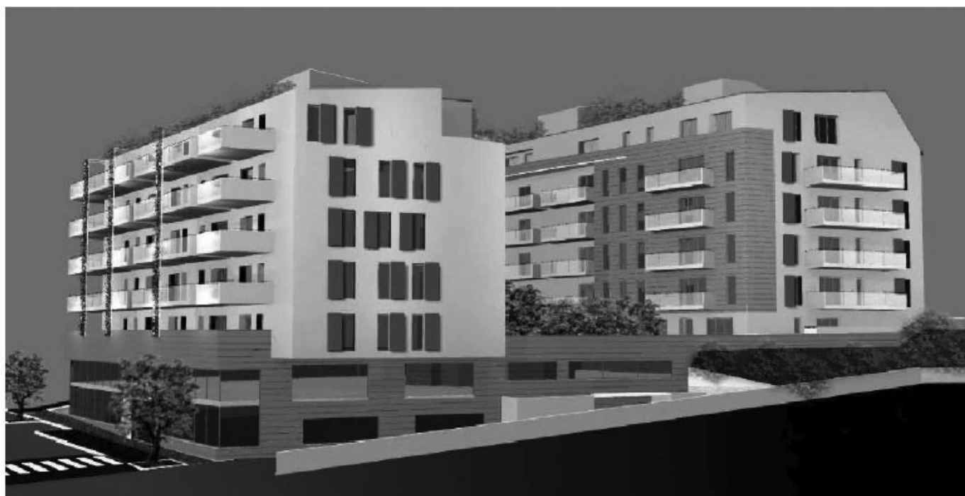
Ancona - Quartiere Palombare. Edificio residenziale per 81 alloggi (Proprietà Soc Comparto 27 Srl - Rimini)
